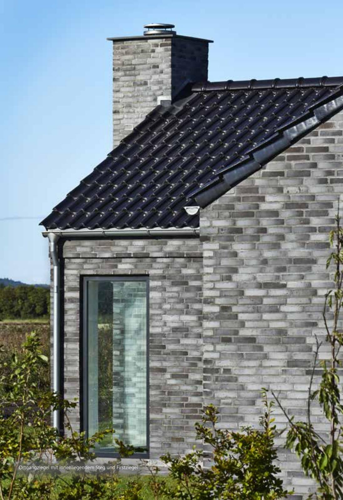
Ortgangziegel mit innenliegendem Steg und Firstziegel
